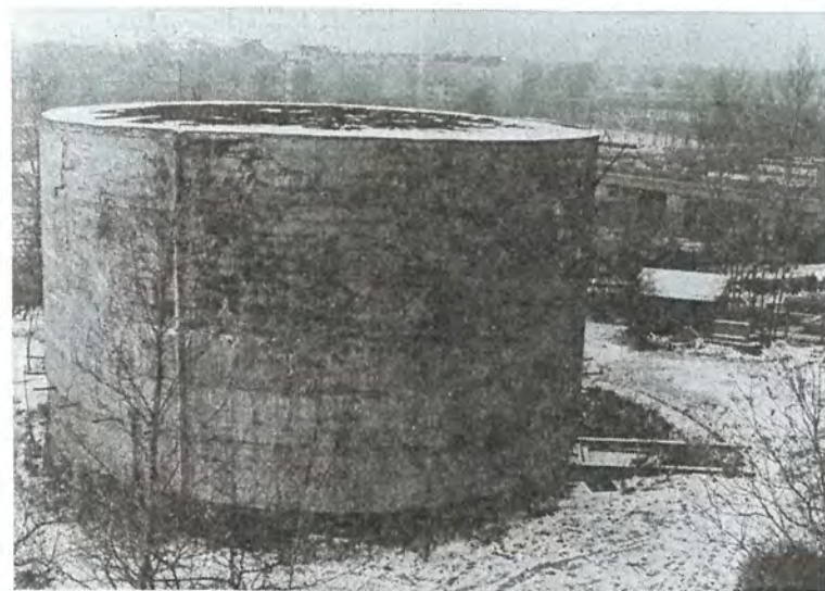
Klotz an der Kolonnenbrücke. Noch immer wird Albert Speers Betonpilz in Tempelhof von TU-Wissenschaftlern für Boden- und Fundamentuntersuchungen genutzt. Foto: Hampel
